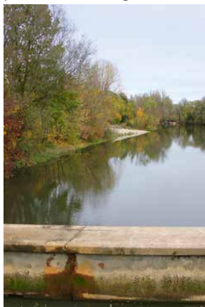
Hier soll der Fischweg entstehen
