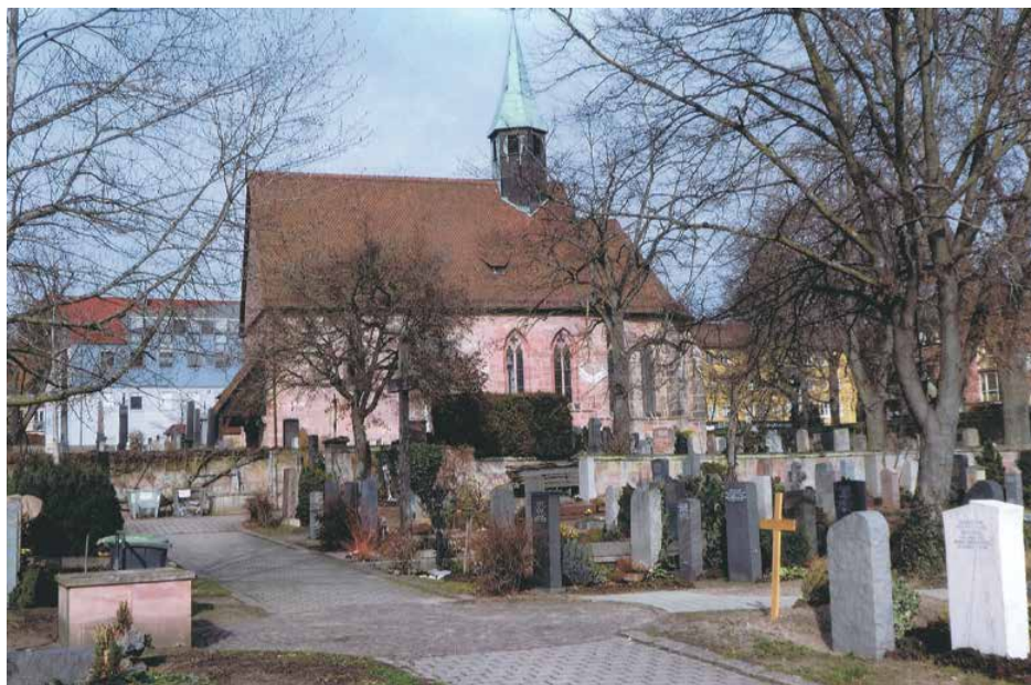
Abb. 7: Das Bild zeigt den Blick von dem 1954 erweiterten Friedhof aus auf die Kirche. An der Südwand, die hier allerdings durch den Baum verdeckt ist, erkennt man noch die Baunaht, die den Kirchenraum von dem Siechkobel (später Pfarrwohnung) trennte (Bild: Rusam 2020).
