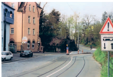
Abb. 7: 2000 nach Abriss der Ringbahnbrücke nach Westen, links Haus Nr. 64. Privatsammlung H. Wolf
