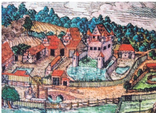
Abb. 1: Inmitten eines Weihers erhebt sich der mit Eckerkerchen und einem Zwinger bewehrte so genannte Groland-Scheurische Herrensitz. Mit großer Wahrscheinlichkeit stand an eben dieser Stelle das feste Haus des 1216 genannten Reichsschultheißen Giselher von Erlenstegen. Das Fachwerkhaus mit dem hohen spitzen Dach links daneben war die 1360 erstmals genannte und um 1930 abgebrochene alte Mühle (Kolorierter Kupferstich von Johann Alexander Boener aus der Zeit kurz vor 1698, Stadtgeschichtliche Museen).
