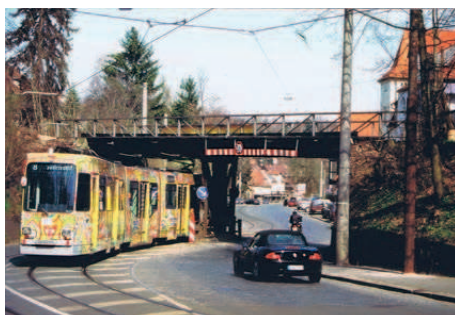
Abb. 6: Ringbahnbrücke vor Abriss 2000 nach Osten Höhe Hausnr. 64. Privatsammlung H. Rusam
