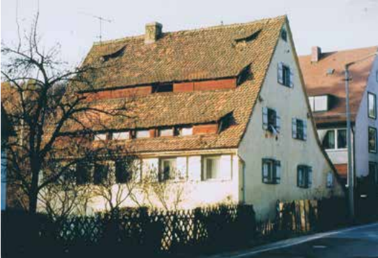
Abb. 5: Das Bild zeigt das Bauernhaus von Johann Stein kurz vor der Renovierung (Günthersbühler Straße 7). Am Dach sind schön die Lüftungsgauben der Darre für das Trocknen des Hopfens zu sehen (Bild: Rusam, November 1982).
