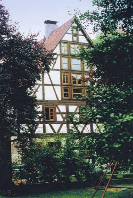
**Abb. 11:** Auf dem Bild ist der West-Giebel des total renovierten Steinschen Bauernhauses zu sehen. Schön erkennt man die in Franken beliebte besonders stabile Fachwerkkonstruktion des „wildes Mannes“. Die Fenstergestaltung wurde mit der Denkmalschutzbehörde im Detail abgesprochen. Während bei vielen Fachwerkhäusern um Nürnberg die West-Seite, d.h. die Wetterseite, aus Sandstein gefertigt wurde, hat man im vorliegenden Fall einen Fachwerkgiebel errichtet (Bild: Rusam, 11. Oktober 1984).
