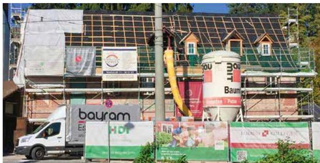
Die Innen- und Außenmauern sowie die Holzbalken des Fachwerks wurden komplett freigelegt. Bereits fachgerecht ausgebessert sind die defekten Holzteile, das Verputzen der Wände mit mineralischem Mörtel steht als nächstes an. Das Dach wird zur Zeit mit Biberschwanz-Ziegeln („Spitzziegel“) komplett neu gedeckt und die alten Fenster durch Stulpenfenster mit schlanken Sprossen ersetzt.
