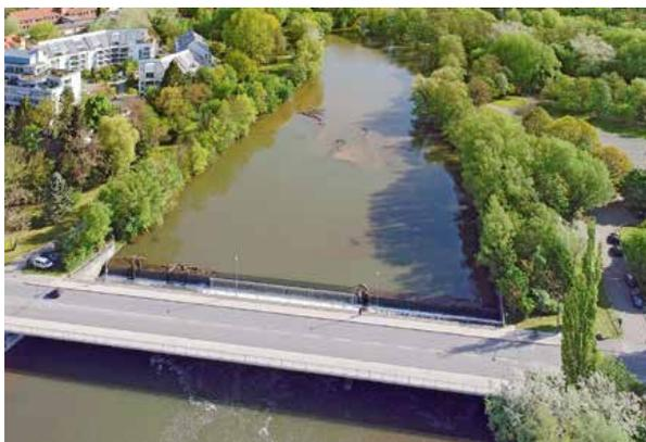
Aus dem Sandfang im Bereich des Seeinlaufes wurden seit Errichtung des Gewässers regelmäßig abgelagerter Sand und Schlamm entnommen. Doch trotz des Sandfanges und dessen Räumungen lagerte sich im unterliegenden Seebereich feines Material und Schlamm ab.
